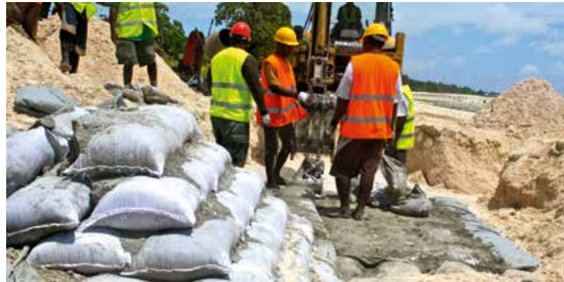
Errichtung von Uferwällen, Tuvalu.
